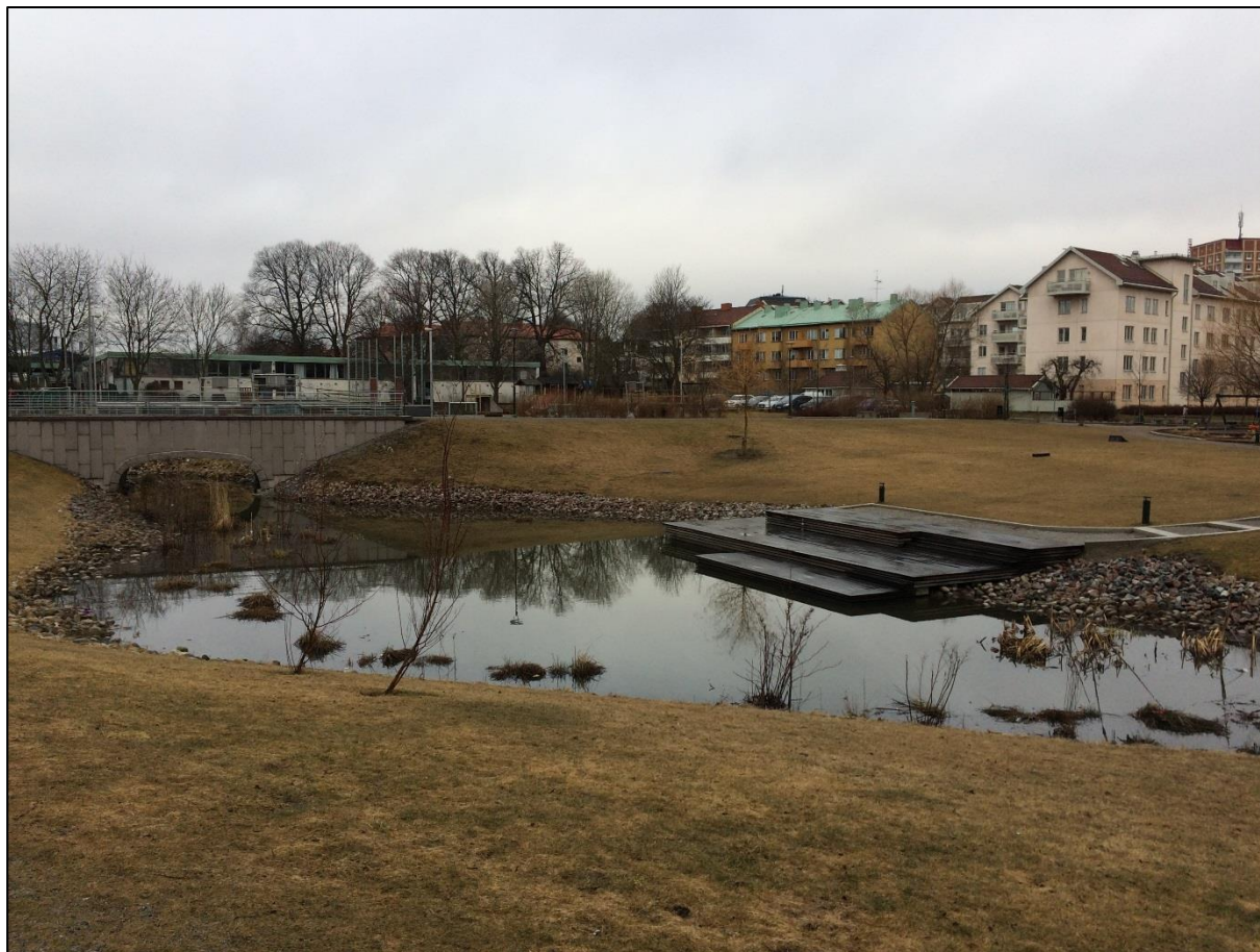
Figur 5-6. Exempel på våt damm, där delar av dammen sträcker sig under en vägbana.
