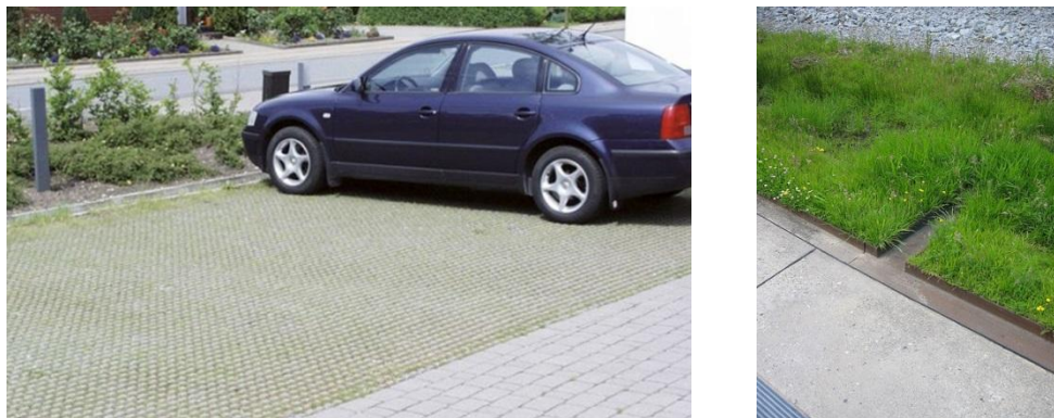
Figur 11 Parkeringsplats med armeringssten samt avrinning mot grönyta
