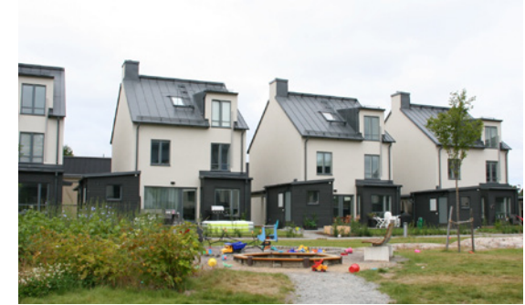
Bild 19. Kedjehus i två och en halv våning. Sköndal, Stockholm.
