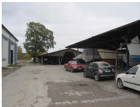
Varvshallar för vinterförvaring (1-4), samt takkonstruktioner (5-6)
