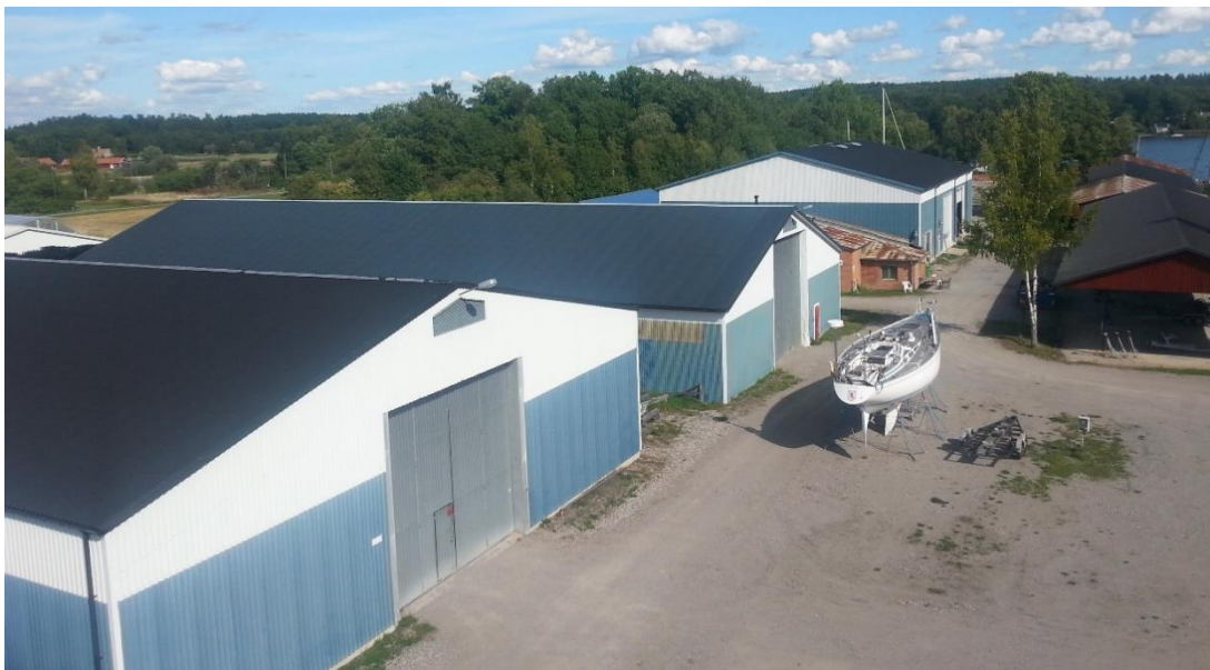
Figur 3 Flygvy över befintliga båthallar inom varvet. De två närmsta byggnaderna är cirka 8 meter i nock och den bortre är cirka 11 meter i nock. Den röda byggnaden är cirka 6 meter i nock. Foto: Tufa Marin.
