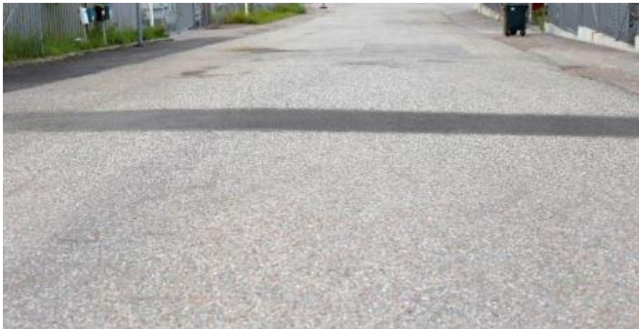
Exempel på återställning av asfalt
